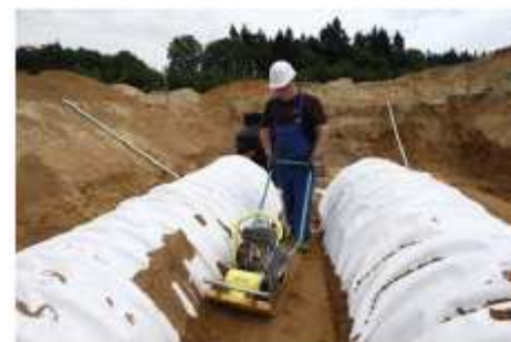
Zhutňování malou vibrační deskou mezi řadami tunelů
