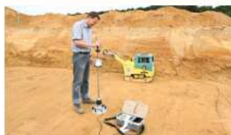
Tlaková zkouška desky v podloží
