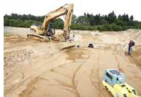
Překrytí tunelového systému
