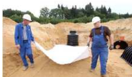
Geotextilie v nátokovém prostoru
