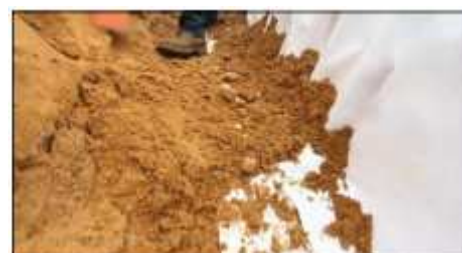
Udusání geotextilie pro upevnění
