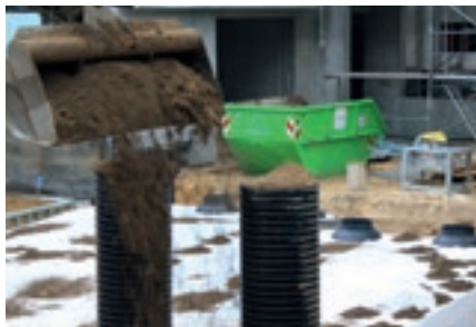
Funkce poklopu pro dobu výstavby při zásypu
